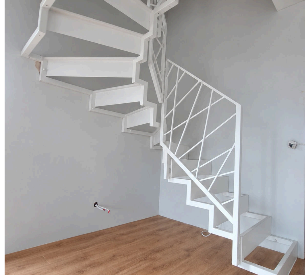
Konstrukcja Balustrada krzyże
