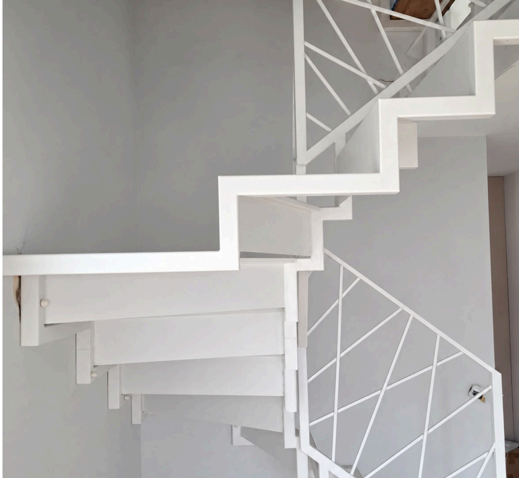
Konstrukcja Balustrada krzyże
