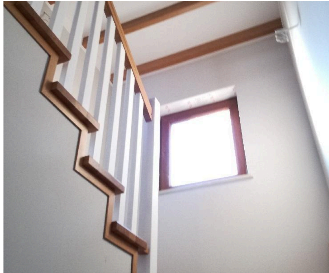
Listwy pod schody
